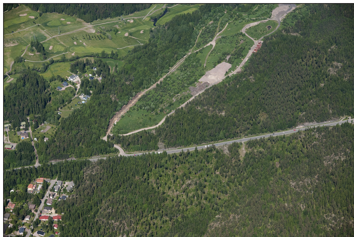
Bild. Området för avloppsreningsverket i Blombacken med omgivningarna.
